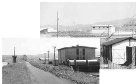
出雲縁結び空港と周辺住宅、農地などの災害防止に昼夜稼働する各排水機場
