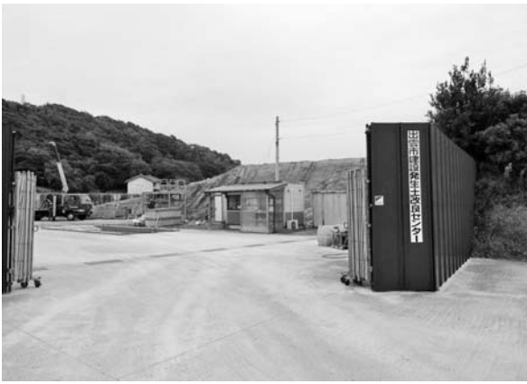
神西沖にある出雲市建設発生土改良センター
