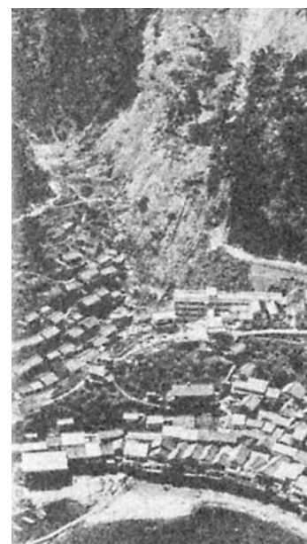
小伊津町（平田）に起きた大規模な土砂災害（昭和40年）：『平田の歩み』より
