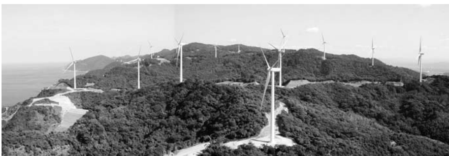
風車間を結ぶ作業用道路
