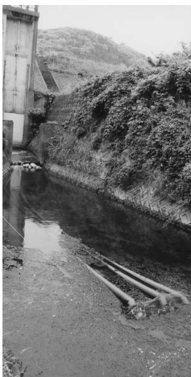
取水ポンプ3台でかろうじて農業用水が確保されている
